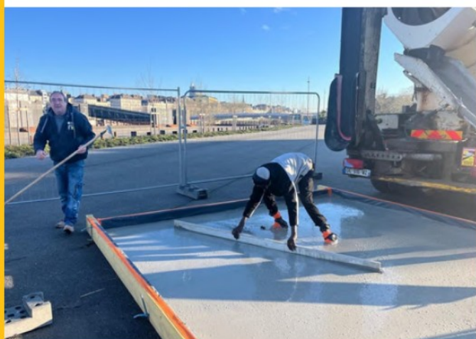
Préparation du socle béton (par l'entreprise MEYER)
